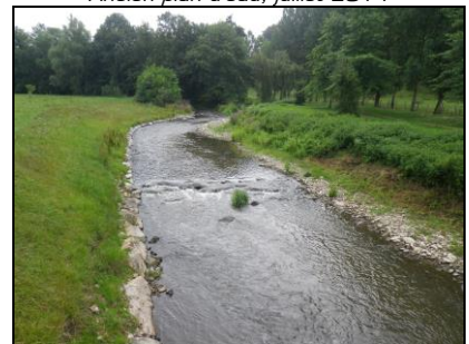
Amont passerelle, juillet 2014
