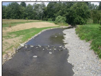
Amont passerelle, août 2013
