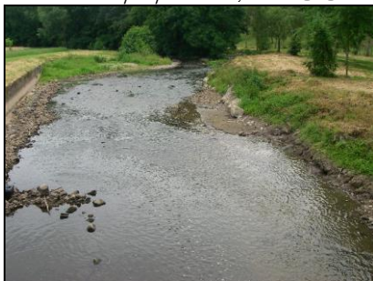
Amont passerelle, juillet 2013
