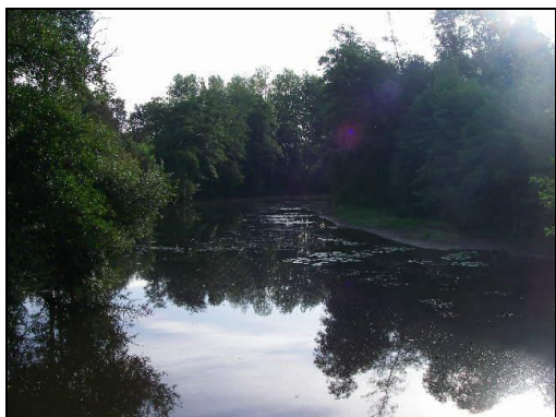
Amont ouvrage en 2009
