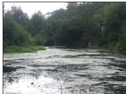
Amont ouvrage en 2012
