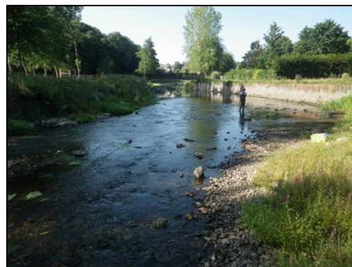
Amont passerelle plan d'eau, 2012
