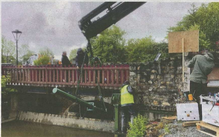
La pose du nouveau vérin effectuée par la société Smit qui assure une maintenance dans les domaines de la mécanique, de l'électricité, de l'automatisme et de l'hydraulique.
