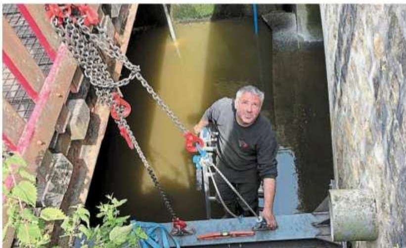
Anthony Fernandez posant et scellant dans le mur les poutres en acier qui vont supporter la pression de l'eau.
