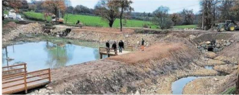
Les travaux pour créer le lit du ruisseau longeant le plan d'eau, la digue, le ponton handi-pêche et la passerelle sur la surverse de crue (à gauche) sont presque terminés.
