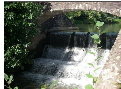
Ouvrage avant démantèlement
