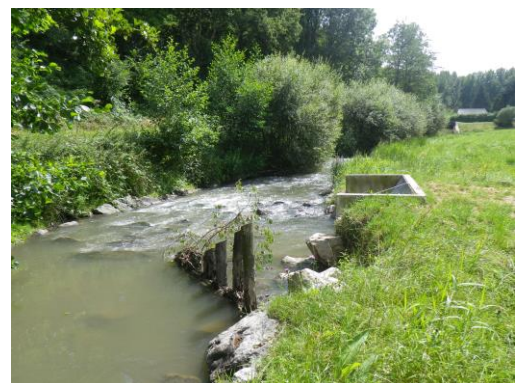
Prise d'eau installée en 2014
