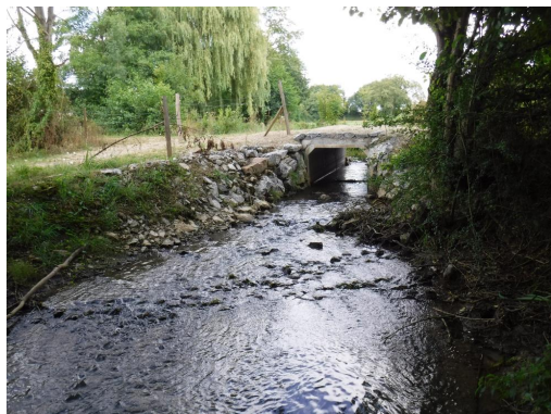
Aval pont cadre 2018
