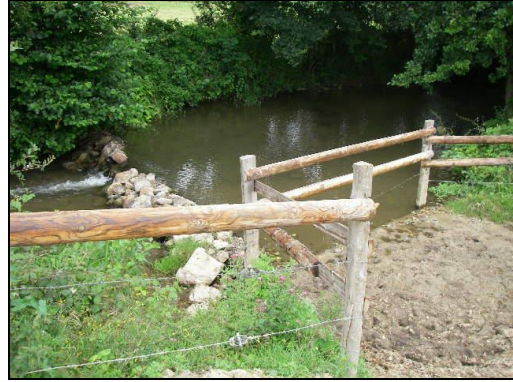
Abreuvoir en aval de l'ancien ouvrage en 2011
