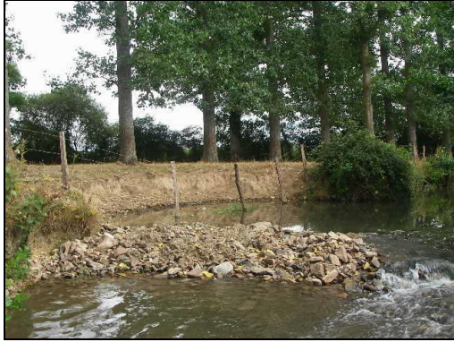
Seuil installé en 2010 par un agriculteur
