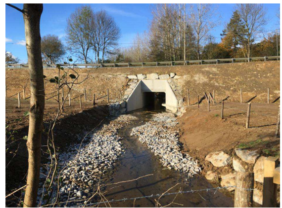
Ruisseau de la Paillardière à AHUILLE (Pont de la RD 500 entre ST BERTHEVIN et AHUILLE remis à neuf par le CD 53) - Recharge du lit et restauration du ruisseau - Installation d'un abreuvoir, de clôtures et d'une passerelle à bovins
