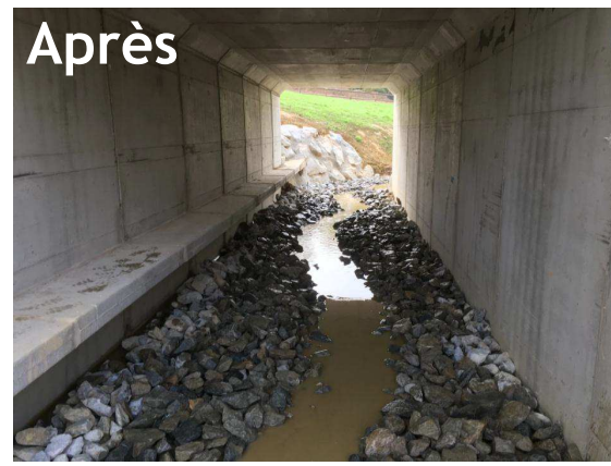
Ruisseau du Galoi à AHUILLE (Pont cadre de la RD 553 entre AHUILLE et ASTILLE remis à neuf par le CD 53) - Enrochement sous l'ouvrage, Reconstitution du lit mineur
