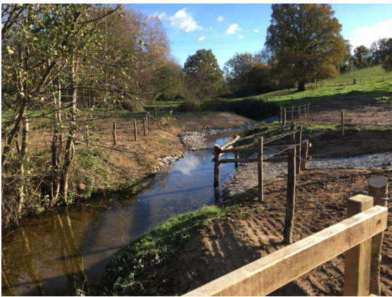
Ruisseau de la Paillardière à AHUILLE (Pont de la RD 500 entre ST BERTHEVIN et AHUILLE remis à neuf par le CD 53) - Recharge du lit et restauration du ruisseau - Installation d'un abreuvoir, de clôtures et d'une passerelle à bovins
