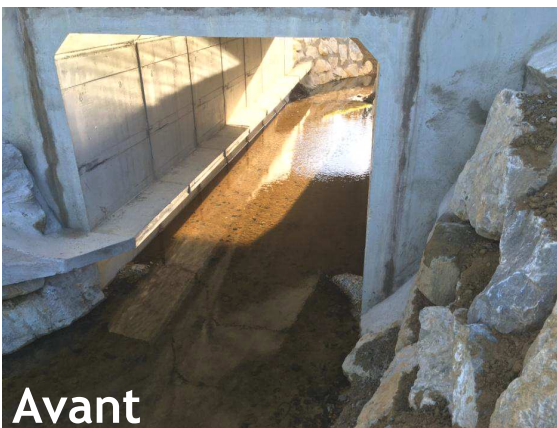
Ruisseau du Galoi à AHUILLE (Pont cadre de la RD 553 entre AHUILLE et ASTILLE remis à neuf par le CD 53) - Enrochement sous l'ouvrage, Reconstitution du lit mineur
